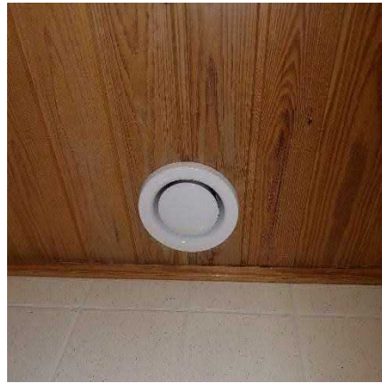
Pesuhuoneen poistoilmaventtiili.
