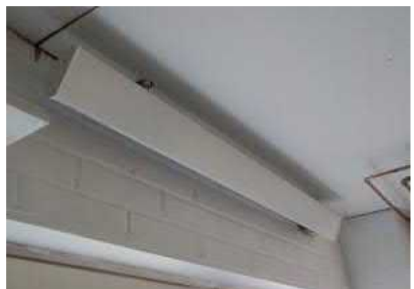
Säteilylämmitin verstaassa
