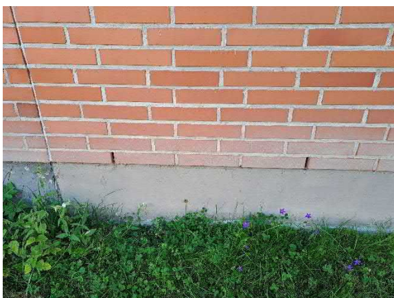
Nurmikkoa/kasvillisuutta kiinni sokkelirakenteissa, joissa paikoitellen viitteitä kohonneesta kosteusrasituksesta
