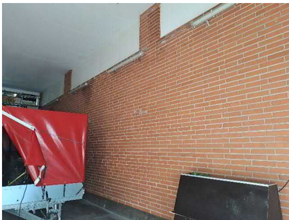
Kalustovaraston ja halliosan välinen seinä on vanha ulkoseinä
