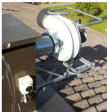
Pakokaasuimurin sähköistystä vesikatolla
