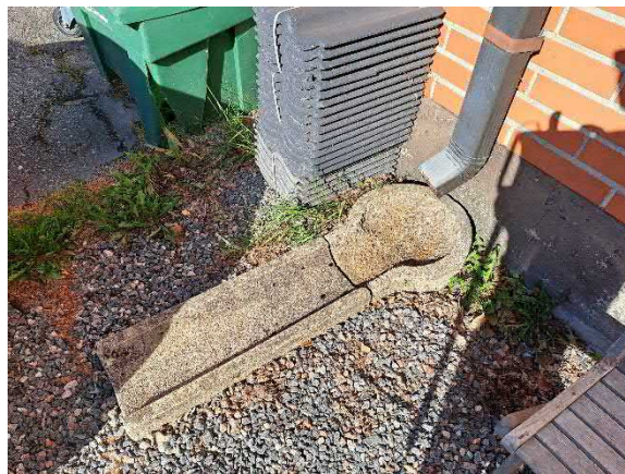
Sadevedet ohjataan osittain betonikourujen avulla kauemmas rakennuksen vierustoilta
