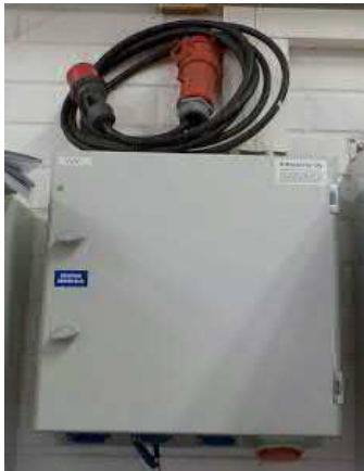
Varavoimakeskus kalustohallissa
