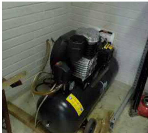
Kompressorin sähköistys seinän läpi
