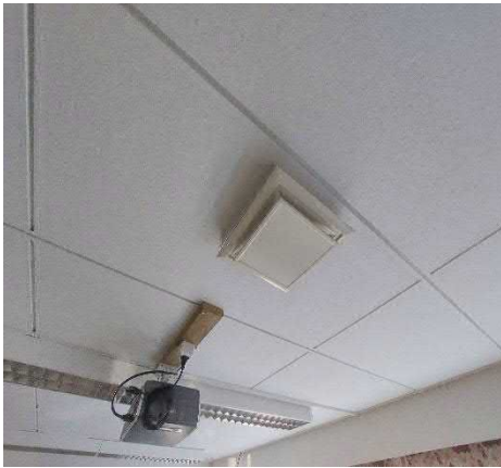
Toimiston tuloilmapäätelaite.
