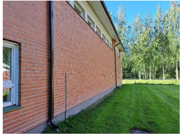
Yleiskuva takapihan puoleiselta julkisivulta
