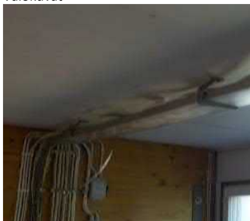
Levyhyllyä kalustohallin parvella
