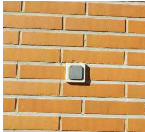
Pistorasia ulkoseinällä
