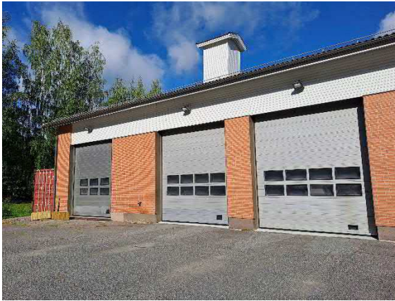
Yleiskuva etupihan puoleiselta julkisivulta
