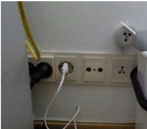
Antennirasia koulutustilassa
