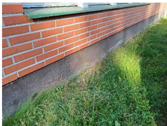
Nurmikkoa/kasvillisuutta kiinni sokkelirakenteissa, joissa paikoitellen viitteitä kohonneesta kosteusrasituksesta
